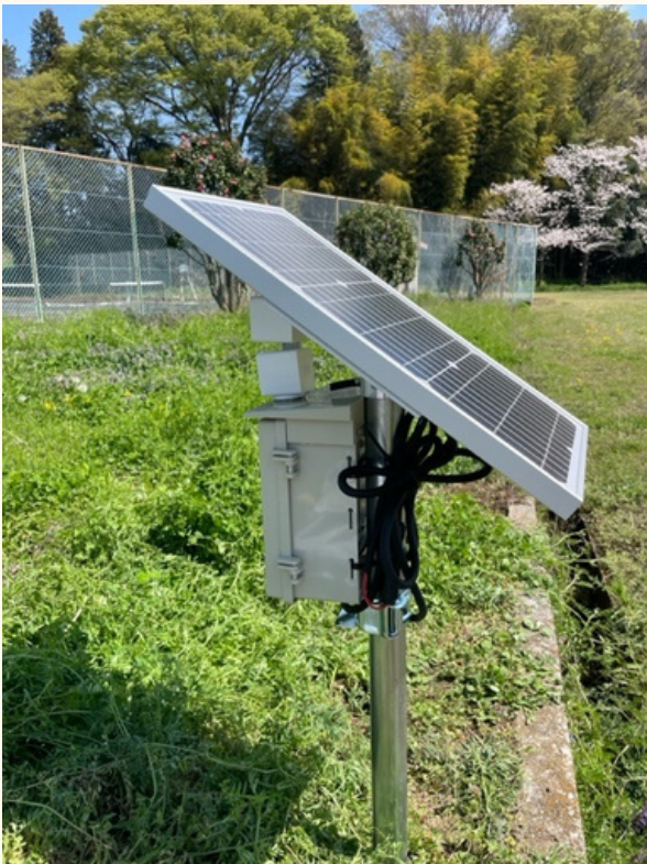
結束バンドでケーブルをまとめているところ ウォルボックスに南京錠など鍵を付けるのも良い
